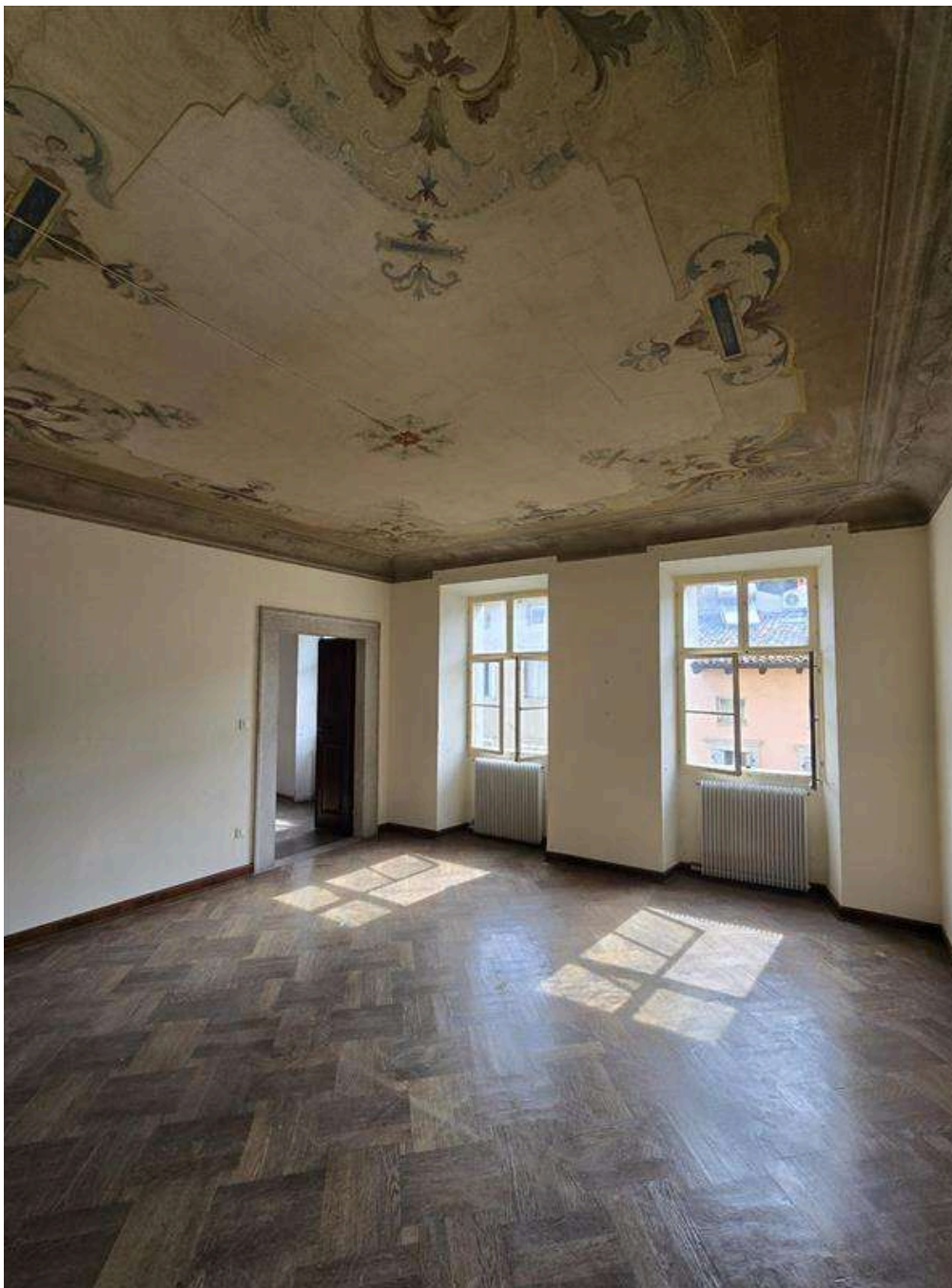
Zona giorno appartamento A5, terzo piano, soffitti affrescati e parquet di pregio (ante restauro).
